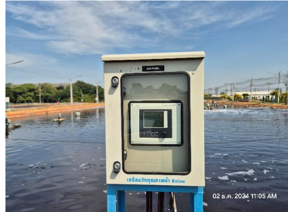
รูปที่ 2-17 ติดตั้งเครื่องตรวจวัดคุณภาพน้ำ Online
