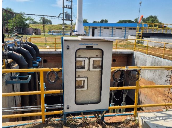
รูปที่ 2-17 ติดตั้งเครื่องตรวจวัดคุณภาพน้ำ Online
