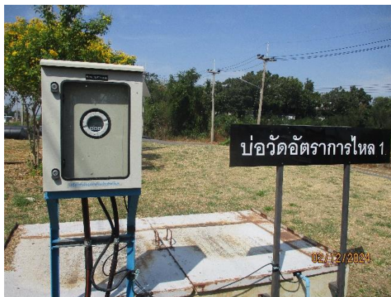
รูปที่ 2-21 ติดตั้ง Flow Meter
