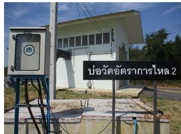
รูปที่ 2-21 ติดตั้ง Flow Meter
